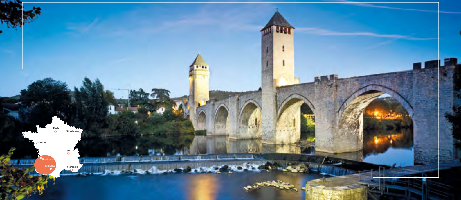
CAHORS - Valentré bridge
